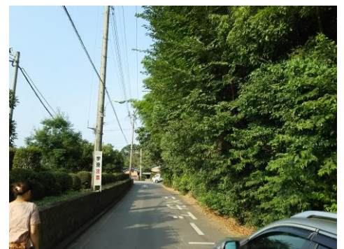
通学路の点検
